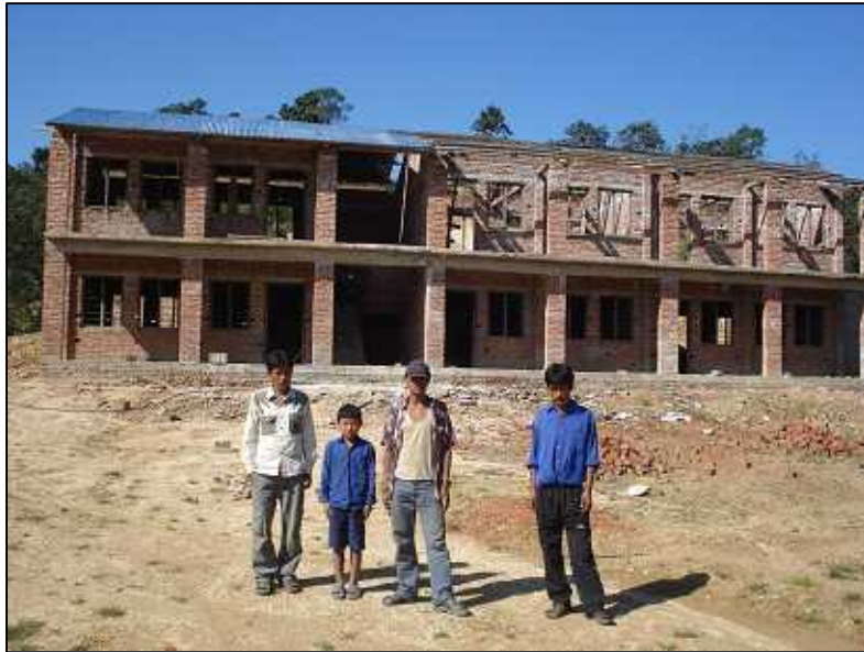
建設中の様子。校舎の形が見えてきました。
