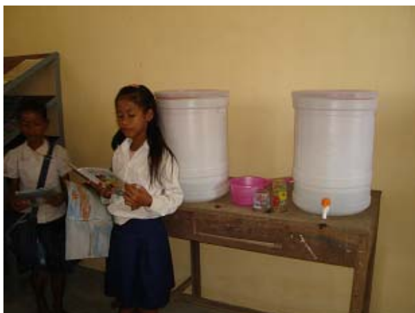
図書室の浄化水槽
