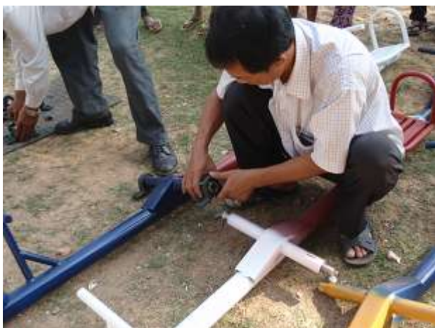
シーソーのベアリングを設置
