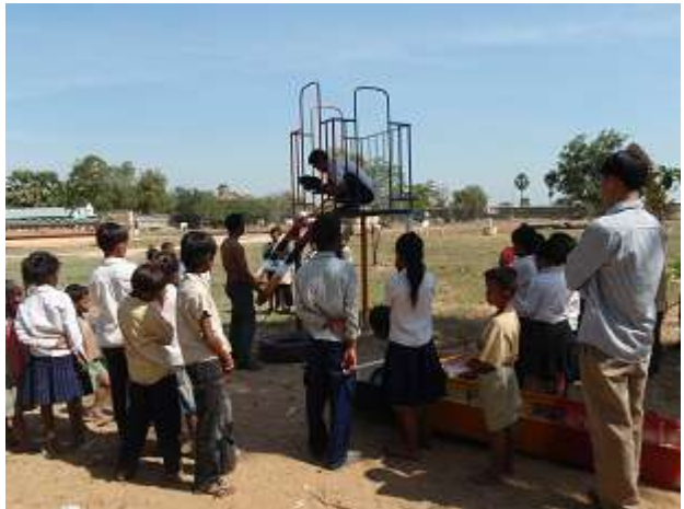
梯子を溶接中
