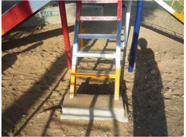
階段にはセメントの土台をつけ補強
