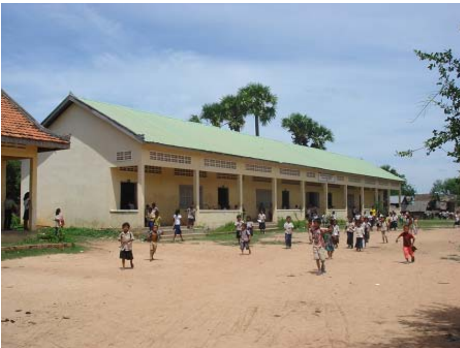
97年建設の1棟5教室
