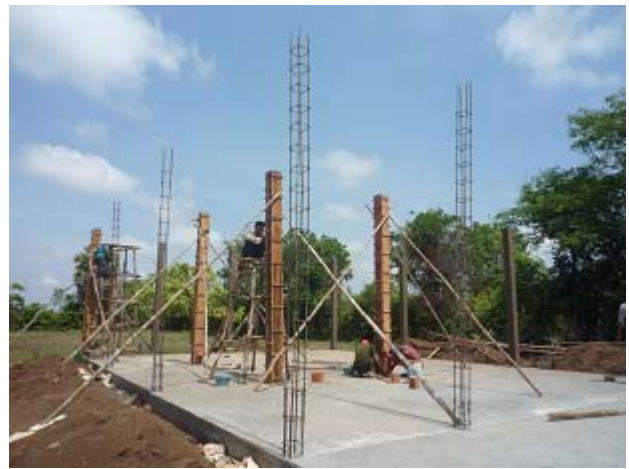
柱の設置をしている様子
