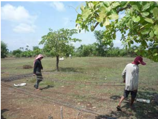
柱の骨組みを運ぶ様子
