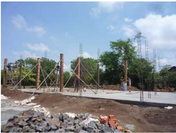
校舎工事現場全景
