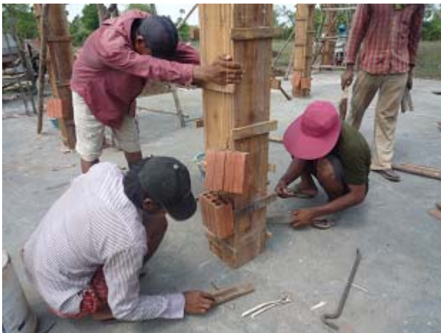
柱設置作業の様子
