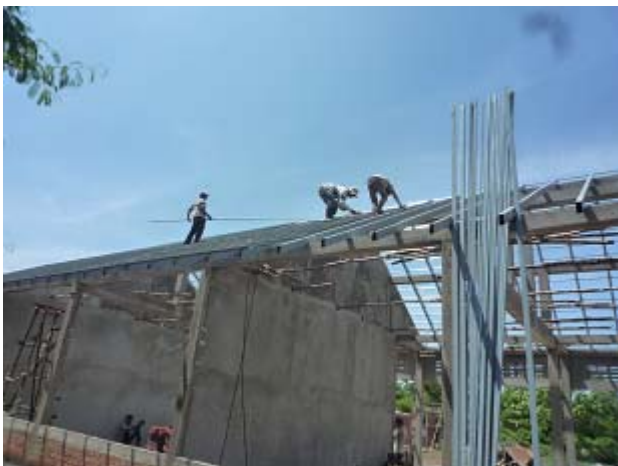
屋根の梁作業
