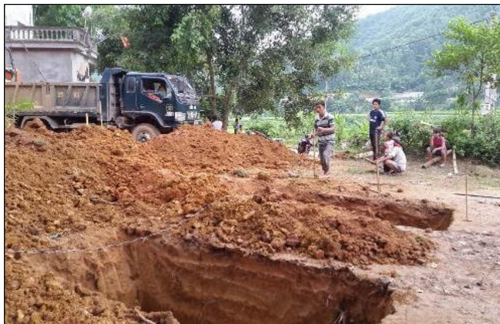
9月より教室の建設工事を開始
