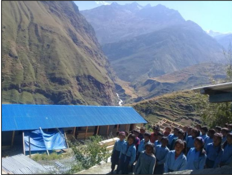
建設中の校舎と児童たち 校舎横には建設中のトイレも見えます。
