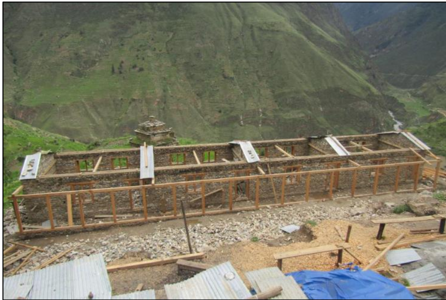
建設中の校舎外観
