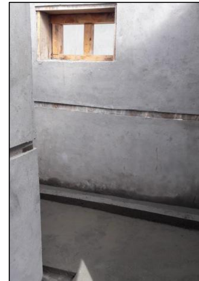
左官工事中のトイレ内部
