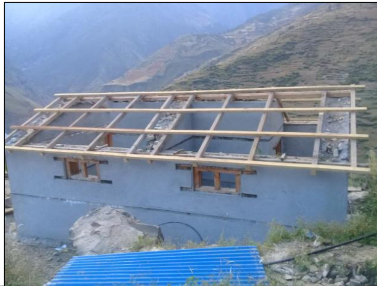
建設中のトイレの外観
