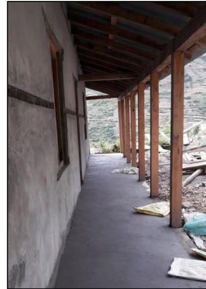
左官工事中の校舎外観
