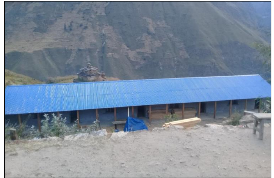
屋根が取り付けられた校舎
