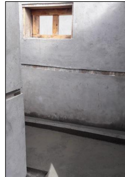
左官工事中のトイレ内部
