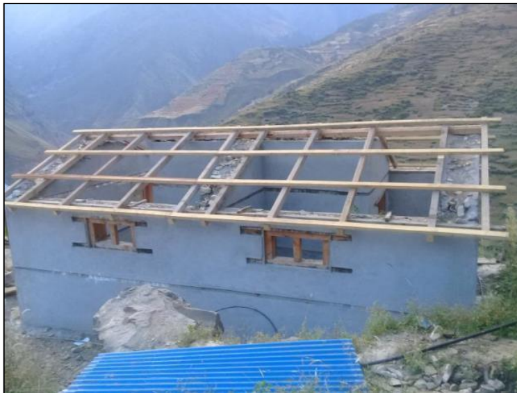
建設中のトイレの外観
