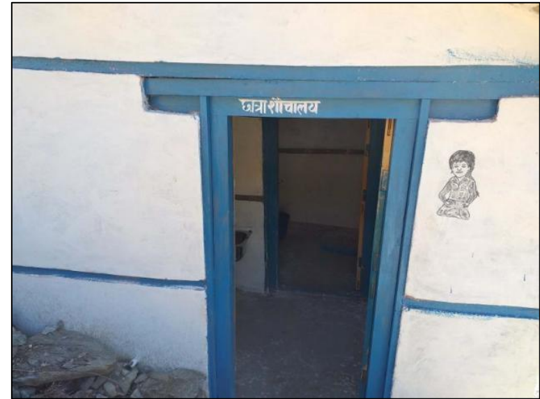
完成した女の子用トイレ
