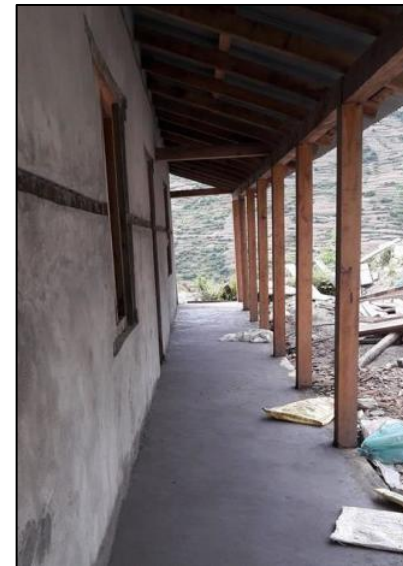
左官工事中の校舎外観
