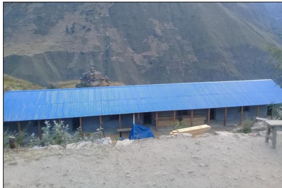
屋根が取り付けられた校舎
