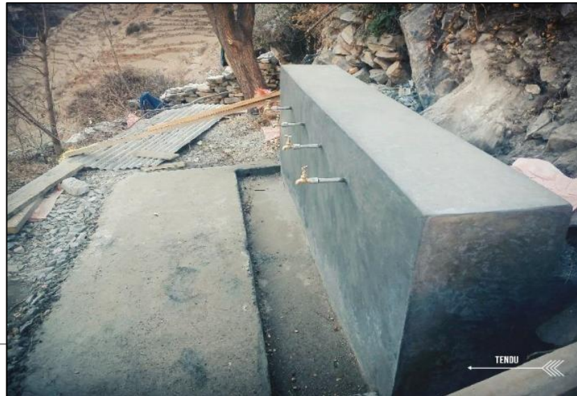
完成した手洗い場。水栓4個を設置
