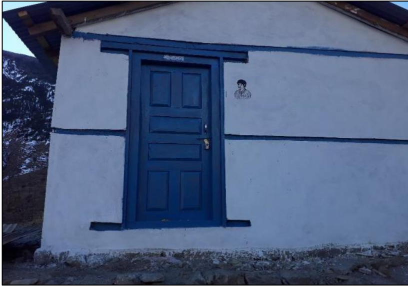
完成した男の子用トイレ
