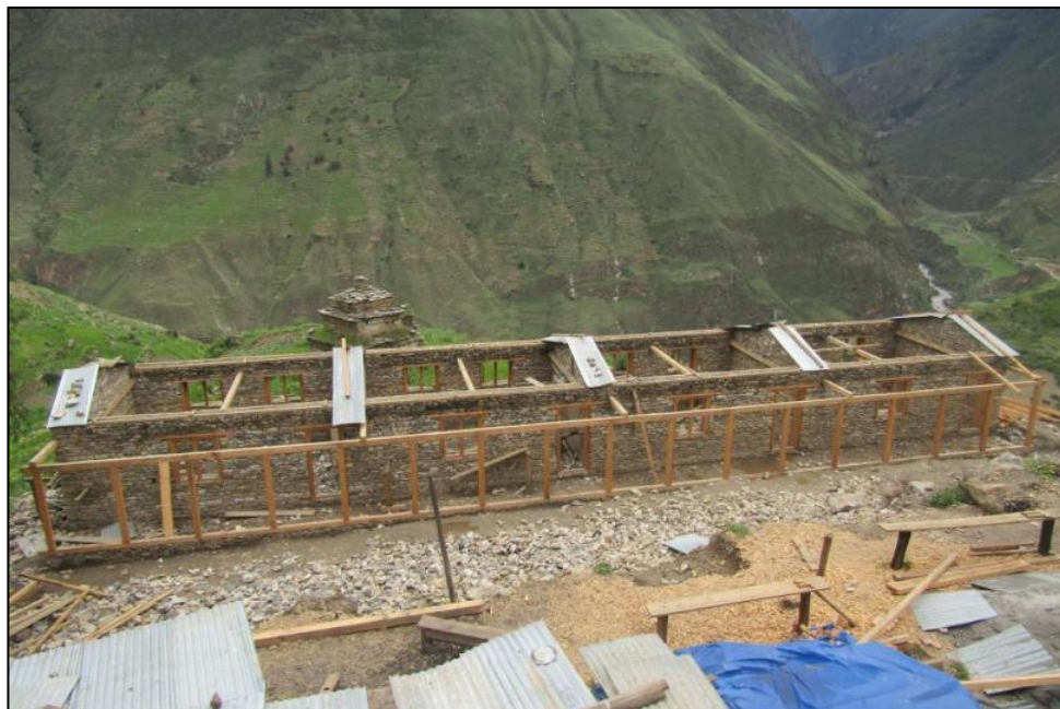
建設中の校舎外観
