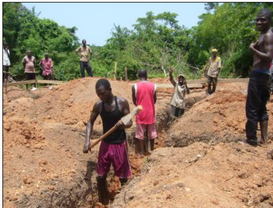
保健所建設プロジェクトで熟練技術の要らない工程で労働力を提供するコミュニティの人々(ガーナ)
