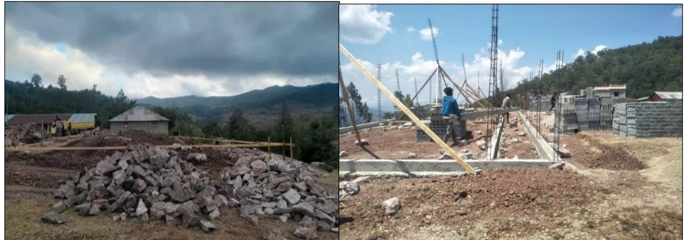
基礎部分の工事の様子
