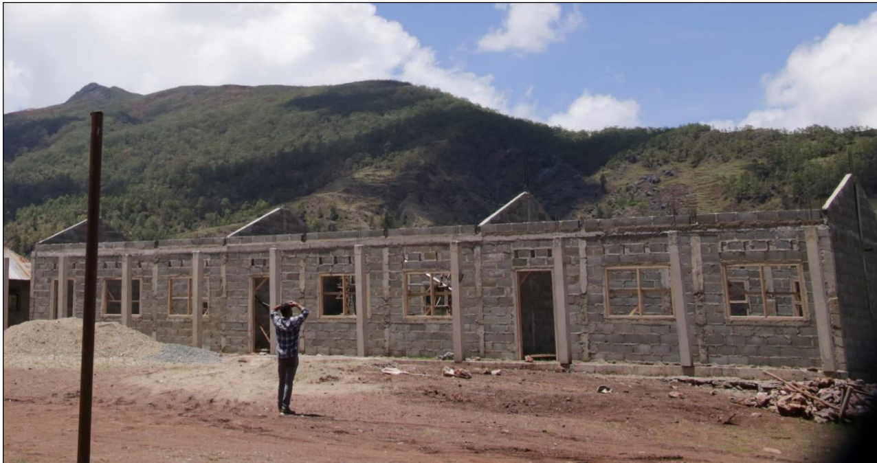
建設中の壁部分
