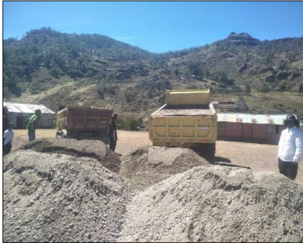
建設地への建設資材の運搬
