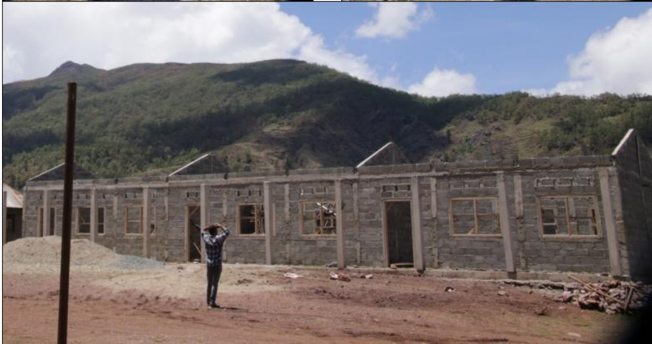
建設中の壁部分
