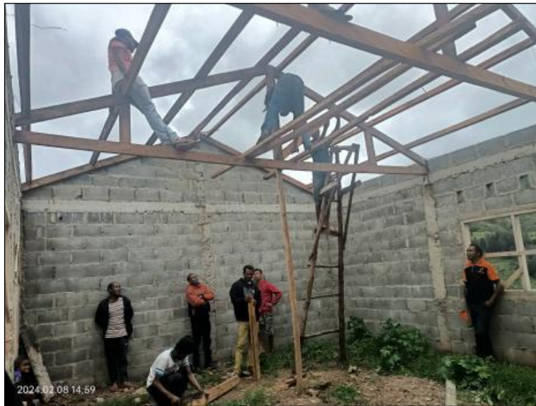
屋根部分の建設の様子
