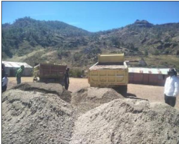
建設地への建設資材の運搬
